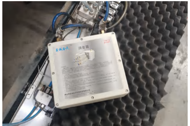
设备真空发声部分加装消声器
