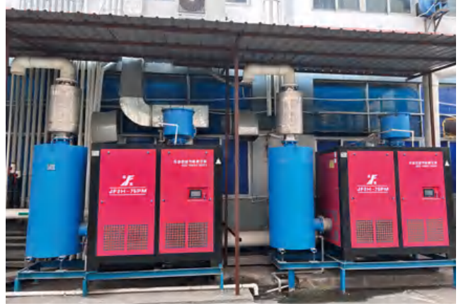
安装新通风换气设施
