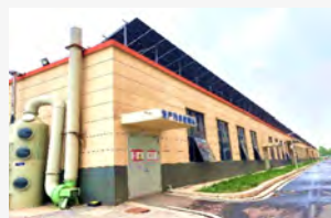
自建废水处理站
